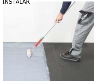
Instalação com o adesivo
